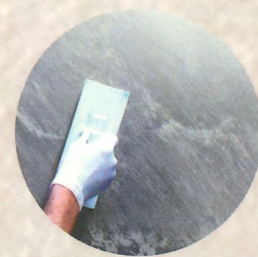
4 Uso della spatola
